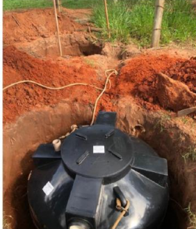
Projeto equipe CATI Regional Botucatu Fossa séptica biodigestora
